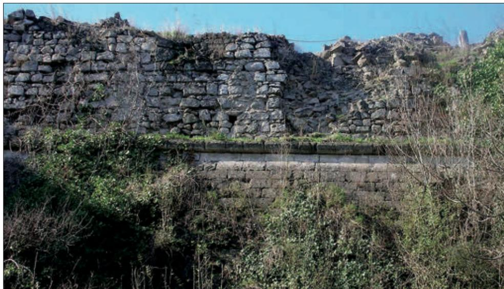
**Fig. 4** – Carinola (CE), castello, fronte est. Si noti la mancanza degli elementi spaccati di tufo grigio campano, un tempo integrati nel muro d’ambito della struttura castellare, oggi danneggiato in più punti. Al disotto, una coltre di vegetazione infestante aggredisce massicciamente la base scarpata realizzata con filari di conci squadrati, rendendo disagiata l’analisi del suo stato di conservazione.
