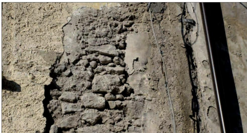
**Fig. 5** – Carinola (CE), chiesa dell’Annunziata, fronte. La lacuna di intonaco disvela l’apparecchio murario in pezzame spaccato di tufo grigio. Ulteriori patologie riscontrate sono patina biologica, distacco e mancanza di materiale. Significativa è anche la presenza di vegetazione infestante erbacea.
