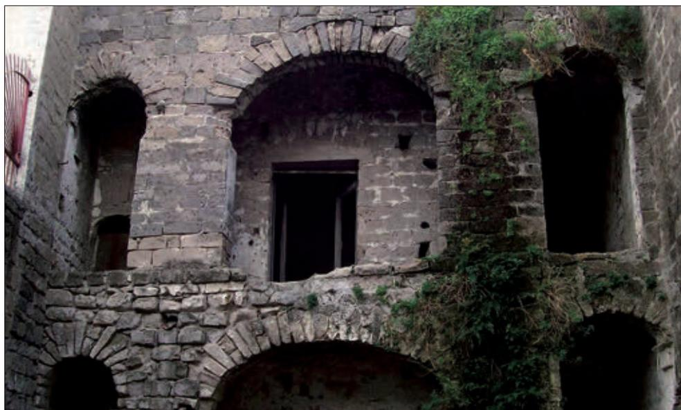
**Fig. 2** – Carinola (CE), palazzo Marzano, corte sette-ottocentesca, fronte est (foto febbraio 2014). Molto estesa è la vegetazione infestante, di tipo erbaceo ed arboreo (fico ariete). Ulteriori patologie riscontrate sono la mancanza di materiale e l'erosione dei giunti di malta. Lo stato ultradecennale di abbandono della struttura ha certamente favorito il formarsi delle suddette manifestazioni di degrado.
