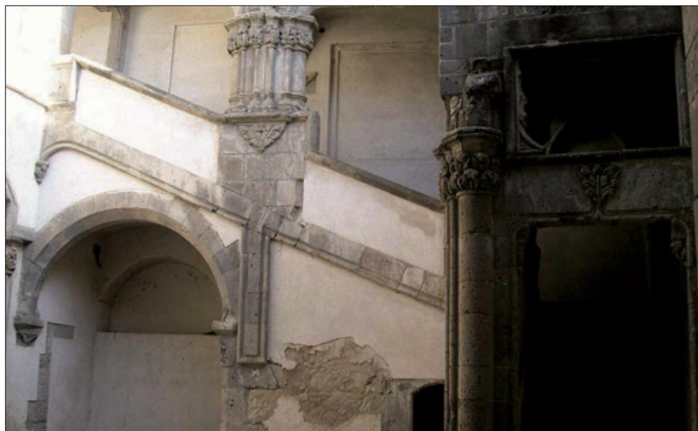
**Fig. 1** – Carinola (CE), palazzo Marzano, corte quattrocentesca, fronte nord. La scala che collega i due livelli della loggia è aggredita da diverse patologie, tra le quali si segnalano lacune di intonaco e incrostazioni.
