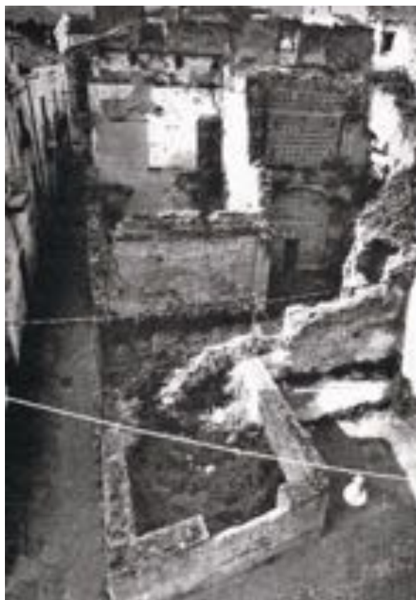
Fig. 22 – Palazzo Marzano, loggia quattrocentesca, scorcio da est, anni settanta del Novecento. La foto documenta le precarie condizioni in cui versava gran parte dell'edificio e rende possibile ipotizzare la presenza di solai lignei al secondo livello, confermata dalle buche d'andito. Ciò avvalorerebbe la presenza di volte soltanto al primo livello, dove queste ultime sono in parte ancora riscontrabili. Al secondo livello, invece, i solai sono stati ricostruiti in latero-cemento (da ROSI 1979: Il palazzo Marzano di Carinola ).
