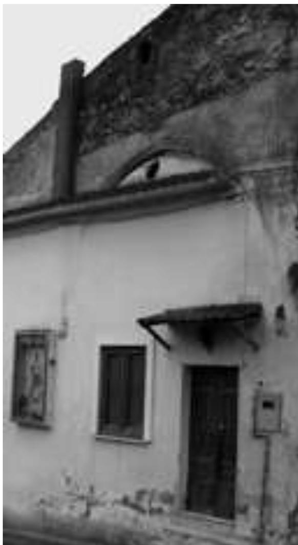
Fig. 44. Carinola (CE), vico Macello, supportico. Diffuse ristilature di malta fine cementizia hanno alterato pesantemente il ritmo originario della muratura facciavista, rendendone difficile la lettura.
