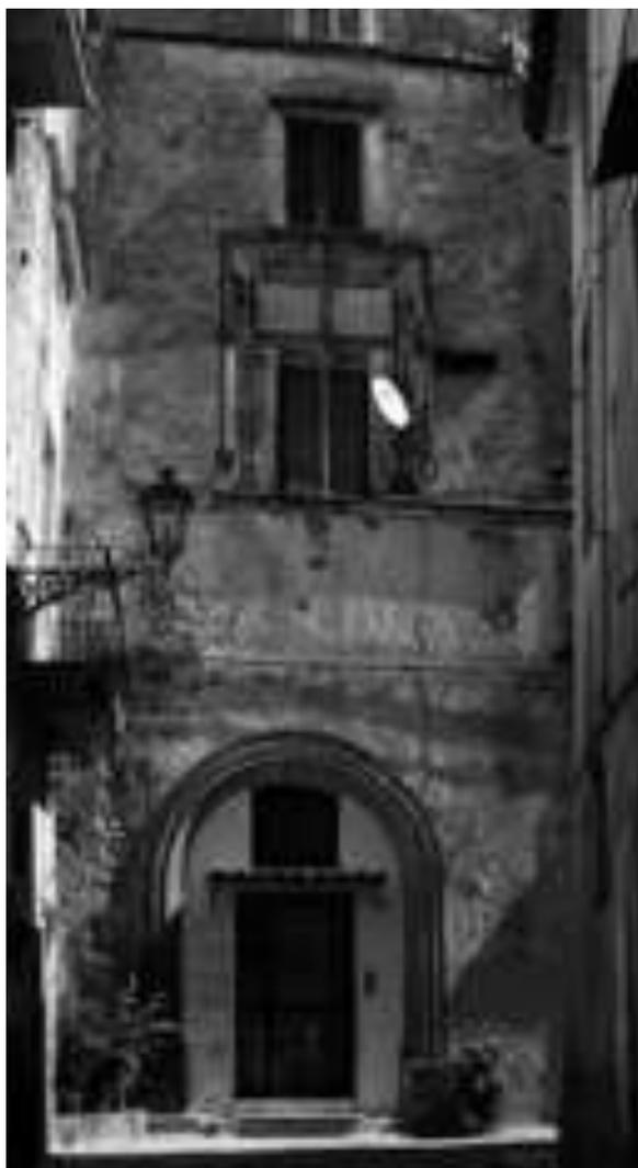
Fig. 61. Teano (CE), fraz. Pugliano, via casa Licciardi, edificio a destinazione abitativa (XV sec.), prospetto principale. In evidenza, la finestra di stilema catalano e l'oculo strombato all'incrocio delle falde del tetto.
