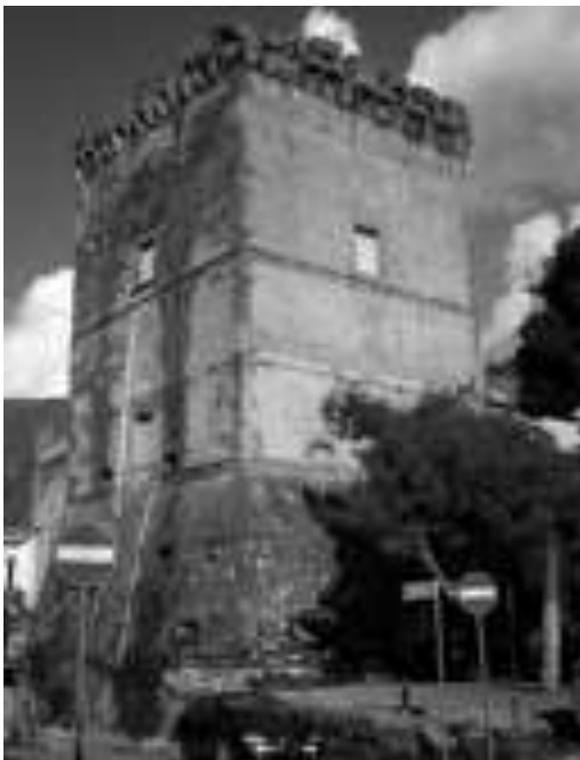
Fig. 77. Carinola (CE), borgo di S. Ruosi, masseria in via Gentili 2, fronte nord-ovest, cantonale "a cantieri" di tufo grigio e giallo. In evidenza, gli "spaccatoni" utilizzati per apparecchiare i ricorsi orizzontali.
