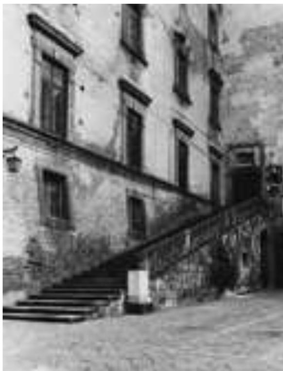
L'analisi odierna del manufatto, condotta applicando i noti protocolli mensiocronologici, registra, relativamente alle strutture murarie, l'uso ricorrente dell'apparecchio "a cantieri", con altezza assimilabile al palmo napoletano o a multipli di esso e, in minor misura, di quello a filari, anch'esso con altezza prossima al palmo e costituenti di lunghezza oscillante, mediamente, da 1,5 a 2,5 palmi.
