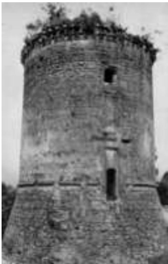
Fig. 40. Pietravairano (CE), torre cilindrica. Si notino le palesi affinità con la torre Marzano: la base di forma tronco-conica, l'ingresso sopraelevato ed il redondone che circonda il corpo cilindrico superiore (Foto S. Merola, S. Palmieri).
