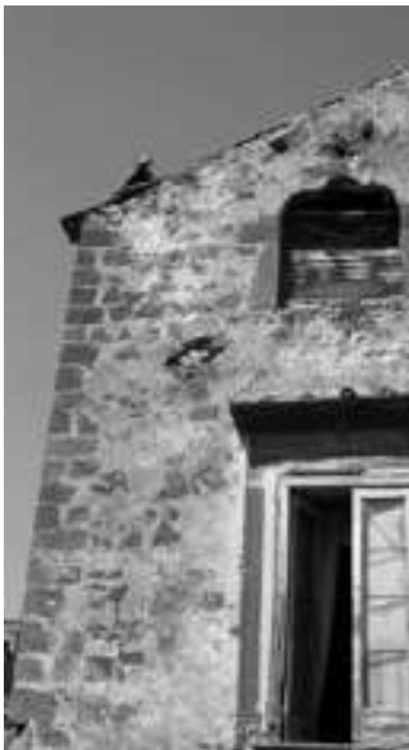
Fig. 75. Sessa Aurunca (CE), edificio in via S. Antonio, cantonale. La soluzione angolare al piano terra è ottenuta con l'utilizzo di due elementi monolitici sovrapposti.
