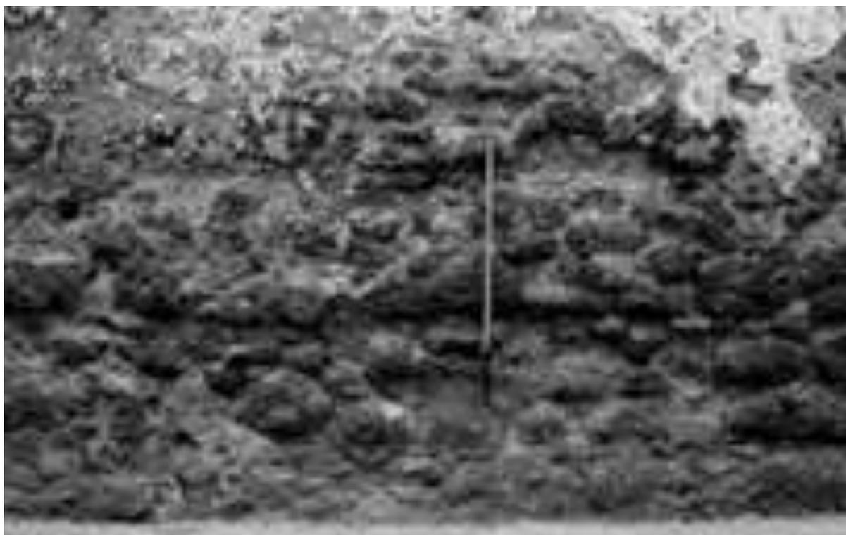
Fig. 57. Sessa Aurunca (CE), edificio in via Spine 14, piano terra, androne, lato sud-ovest, muratura "a cantieri" di tufo giallo (XV sec.) alti 45-52 cm.
