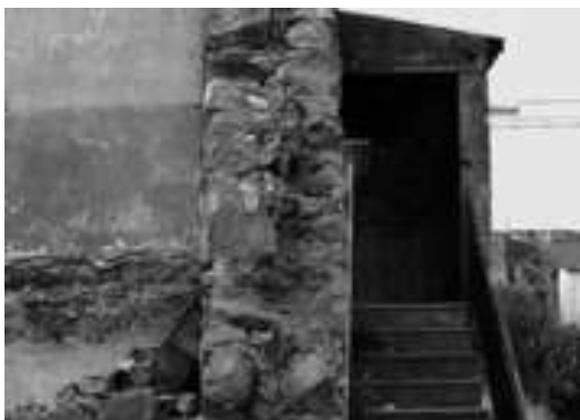
Fig. 69. Castel Volturno (CE), borgo di S. Castrese. Elementi decorativi superstiti di un edificio diruto, le mensole, di foggia quattrocentesca, sono realizzate con l'utilizzo di costituenti di tufo grigio accuratamente lavorati.
