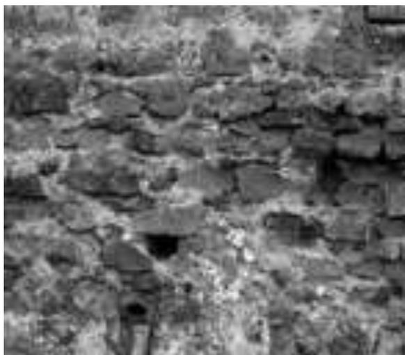
Fig. 73. Carinola (CE), castello, fronte sud-ovest, primo livello, cantonale in tufo grigio (XV sec.). Parte integrante dell'ampliamento quattrocentesco del fortilizio, l'angolata è apparecchiata facendo ricorso a costituenti squadrati di tufo grigio, collocati in lungo e in largo, di altezza pressoché identica, pari a 27 cm circa.
